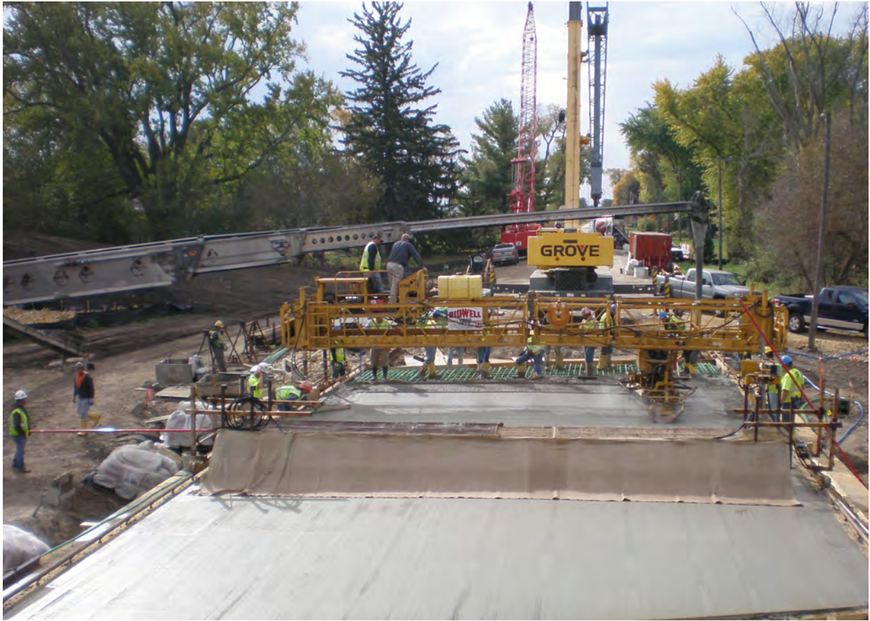
Deck pour in a restricted corridor.
