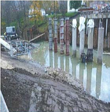
Pouring Piers on Blivin Road Bridge
